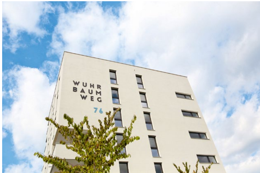
Auch von oben „oho“: Der Sonne entgegen mit einer Solaranlage, auch das Lüftungsgerät „wohnt“ auf dem Dach.
