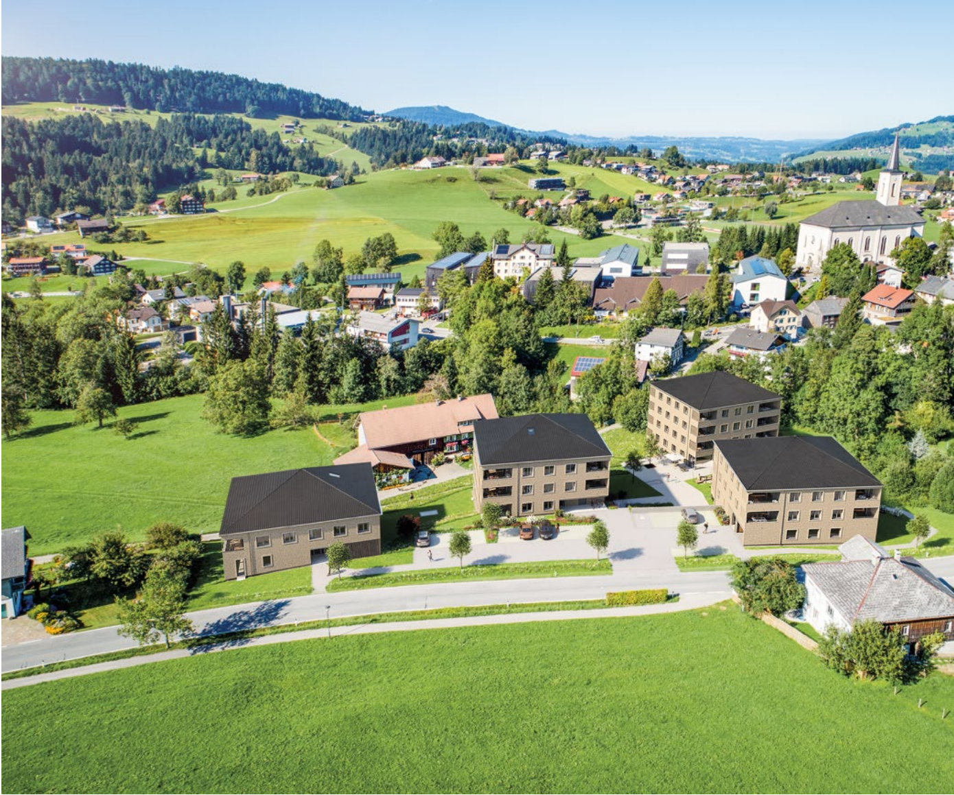
Vier gewinnt: Die moderne Wohnanlage der Sohm Objektbau GmbH mit ihren vier Gebäudekörpern entsteht mitten im Herzen Alberschwendes.
