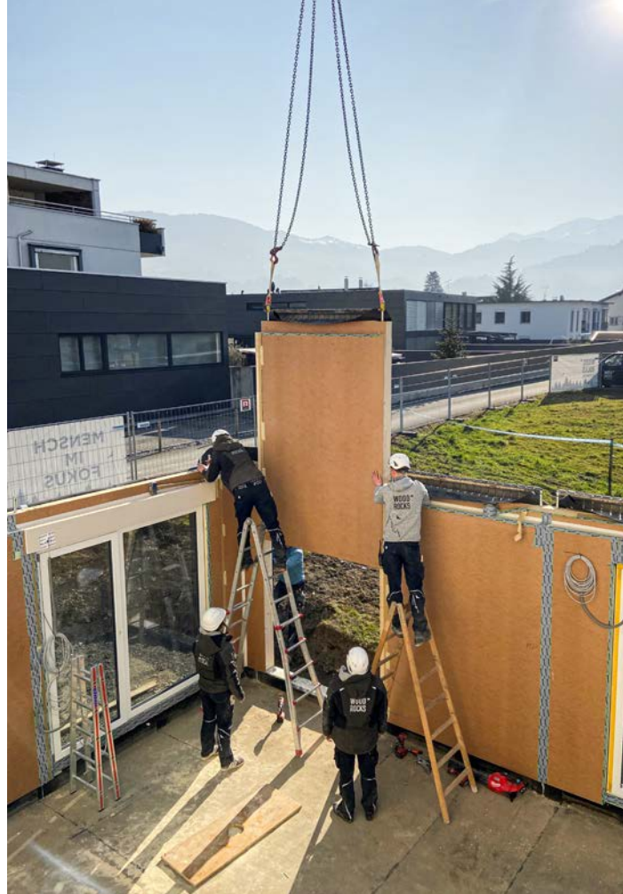
Die Wohnanlage wurde von WoodRocks Bau-Mitarbeitenden – Kaufleute, Planer:innen, Vertriebsmitarbeiter:innen – eigenhändig errichtet.
