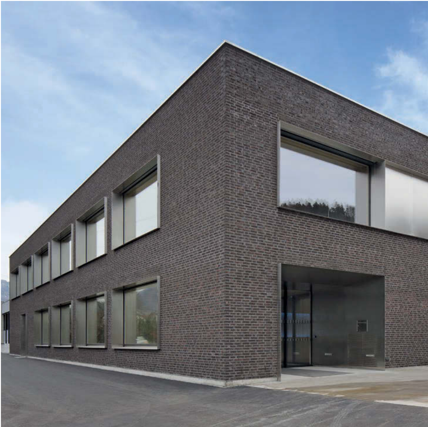
Fassade bestehend aus Backstein sowie die seitens Wagner erzeugten Fenstereinfassungen aus Chromstahl
