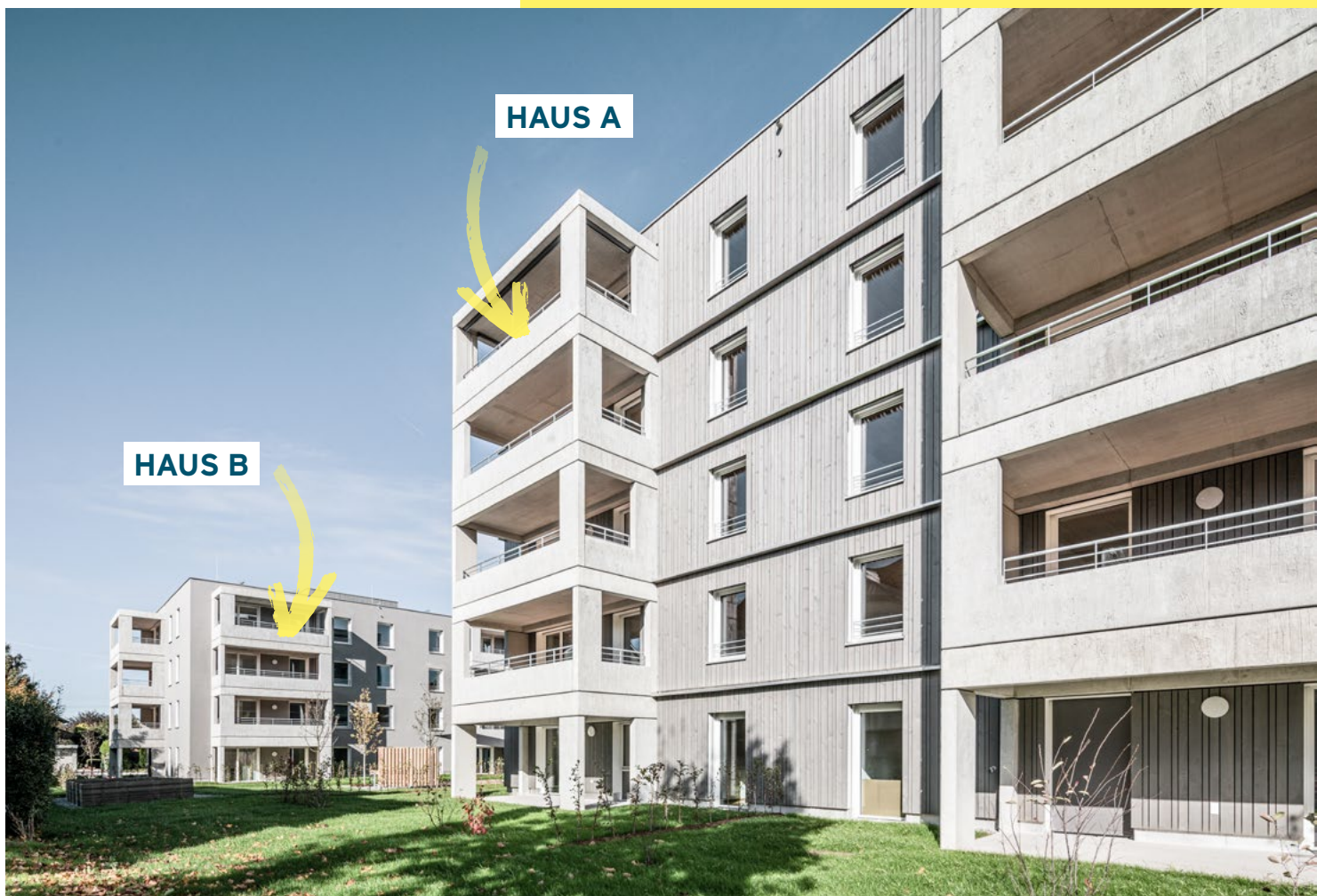
Kampf der Energiesysteme: In der Wolfurter Lerchenstraße stellt Rhomberg Bau den Vergleich an.
