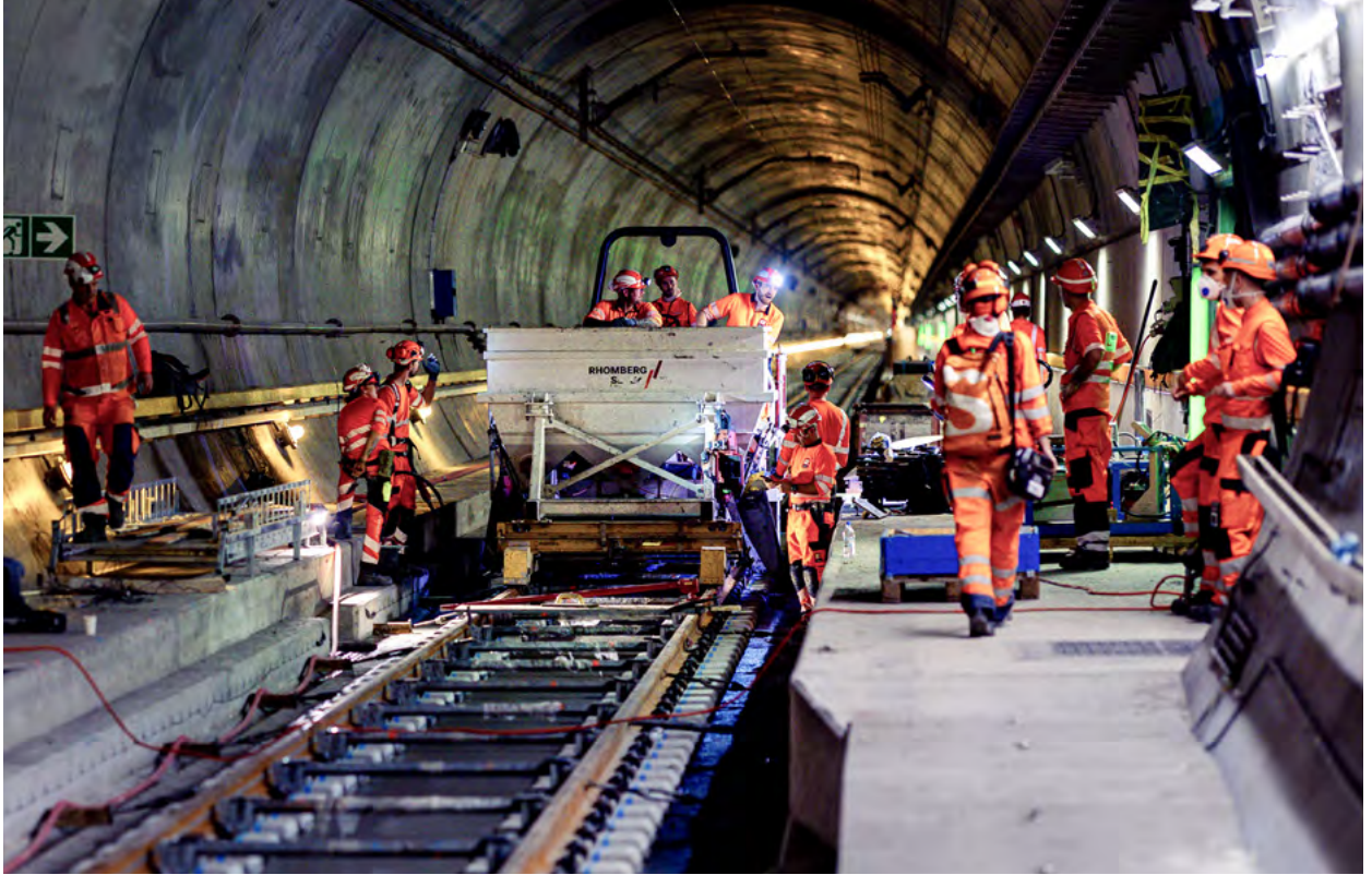
Im Gotthard-Basistunnel haben zwei Parteien von Rhomberg Bau bei Bahnbauarbeiten unterstützt.
