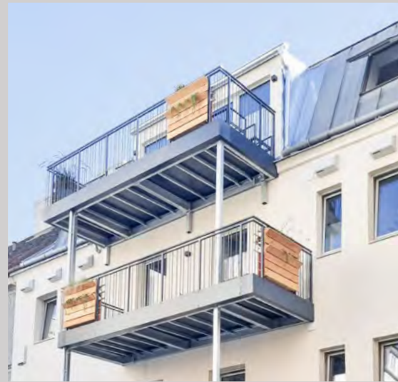
Mit Balkonen im System von Rhomberg wurde das über 200 Jahre alte Gebäude aufgewertet.
